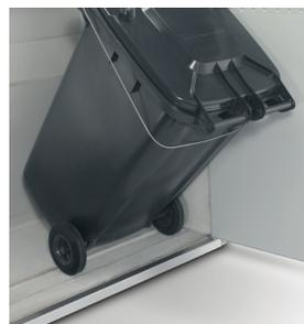
Bodenaussparung für 2-Rad-Behälter mit 240 l Volumen
