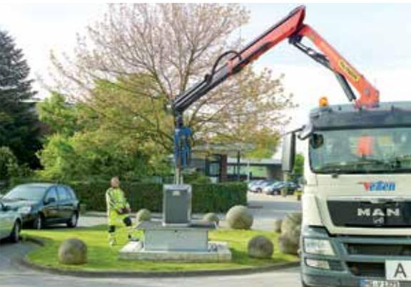
3. Der Behälter wird jetzt langsam und gerade aus dem Betonschacht herausgezogen ...
