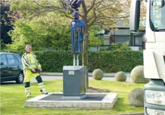
1. Das Kranaufnahmesystem greift die Zugstangen. Beide Zugstangen werden hier gegriffen, jedoch nicht angezogen.
