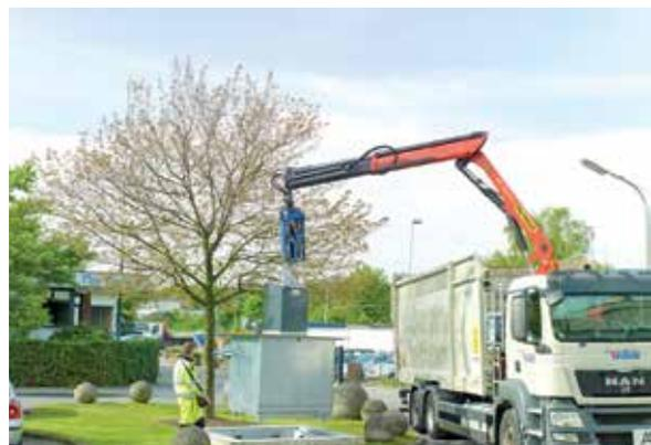
6. Nach dem Entleeren wird die bewegliche Zugstange wieder angezogen und der Behälter über den Betonschacht gehoben und langsam eingesetzt.
